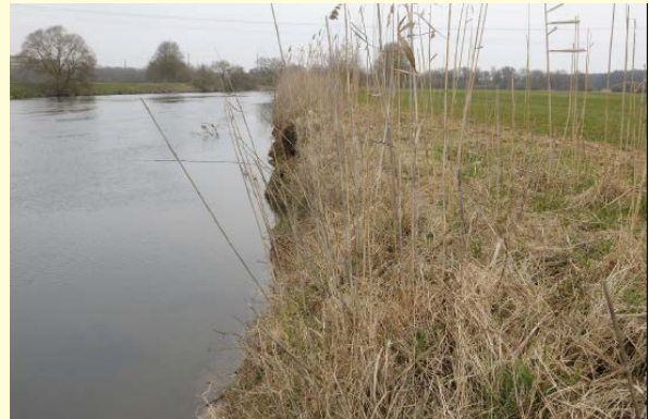
Zustand vor dem Umbau
